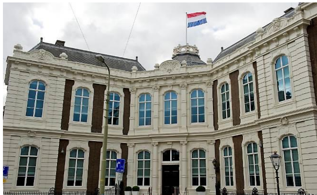
Gebouw van de Raad van State in Den Haag
